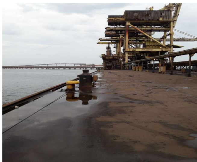
Figura 17: Berço 201 Fonte: EVTEA – Pier3 - 2018
