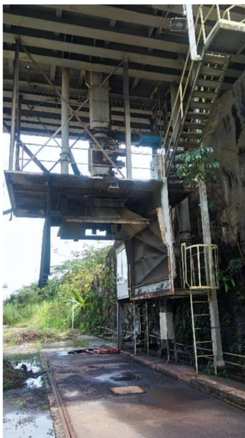
Figura 13: Estação de Carregamento Rodoviário Existente. Fonte: EVTEA – Pier3 - 2018
